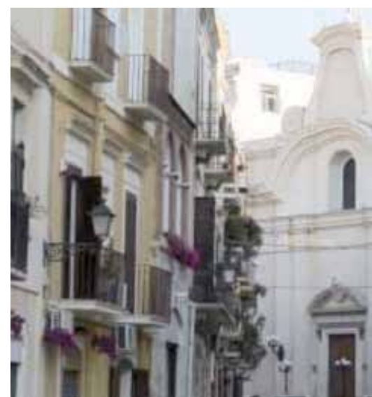
Chiesa di san Domenico, facente parte del Convento ristrutturato
